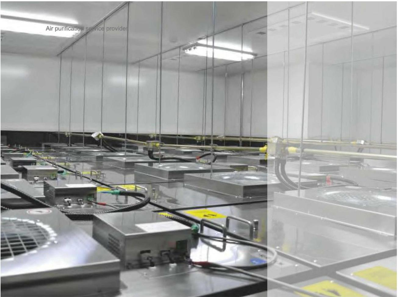
**设备用薄型风机过滤机组**
